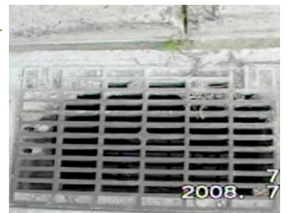
▲ 上) 工場敷地外と隣接している場所にスラッジケーキを野積みしている状況 下) 生コン汚水の流れ込んだ形跡が残っている下水の側溝＝グレーチング
